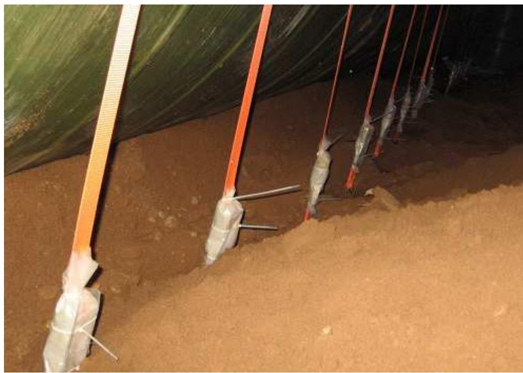
Установка емкости на плите, крепление стяжных ремней
