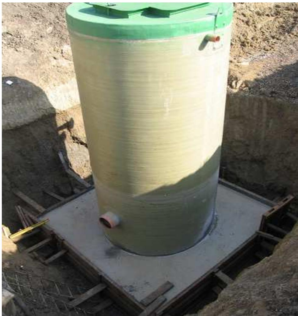
Установка вертикальной емкости, анкерение и бетонирование.
