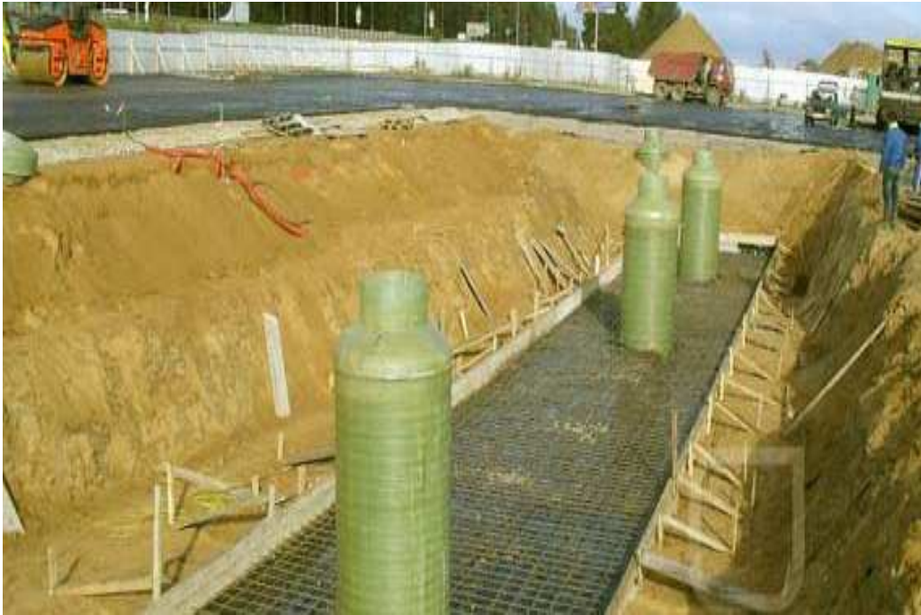
Изготовление распределительной плиты
