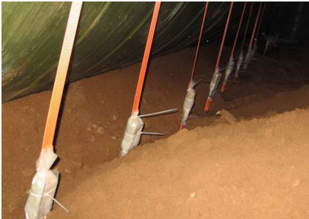
Установка емкости на плите, крепление стяжных ремней
